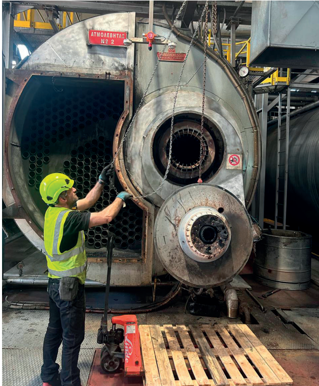
Συντήρηση λέβητα – αποξήλωση παλαιού καυστήρα
