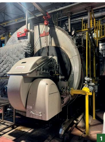
1. Καυστήρας Φυσικού αερίου σε λειτουργία 2. Νέος καυστήρας WEISHAUPΤ πριν την τοποθέτηση
