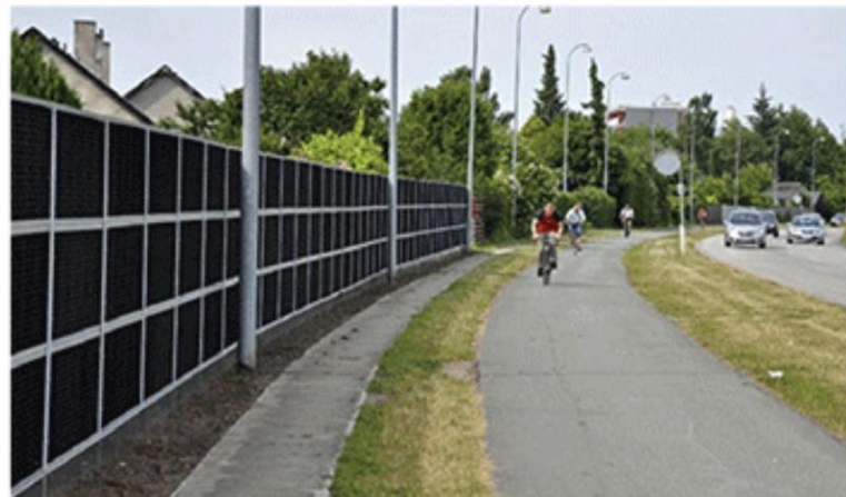
Ηχοπετάσματα από ανακυκλωμένα σύνθετα υλικά, Κοπεγχάγη Δανία. Πηγή: Miljoskarm.dk
