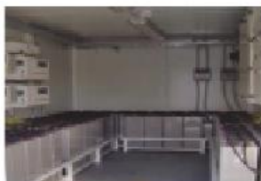
Σχήμα 4: Η διάταξη των συσσωρευτών (3.000Ah, 48V)
