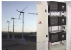
Σχήμα 3: Η διάταξη των τριών Α/Γ (σύνολο 3kWp) της εφαρμογής με τους αντίστοιχους φορτιστές συσσωρευτών
