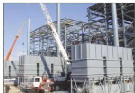
Φωτ.2,3,4. Στάδια κατασκευής των RTOs.
