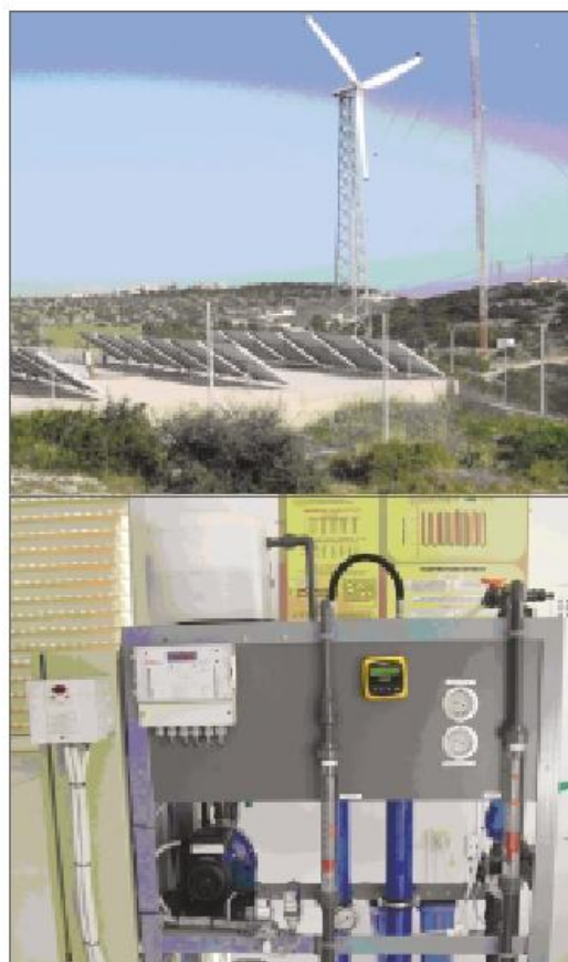
Κερατέα, ΚΑΠΕ, 130lt/ώρα μονάδα A/O
