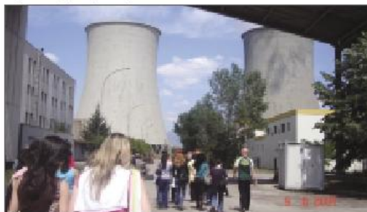
Φωτογραφία 2: Οι πύργοι ψύξης στον ΑΗΣ Καρδιάς ύψους 20 μέτρων χρησιμοποιούνται για να ψύχουν το νερό χρησιμοποιώντας τον αέρα. Το νερό ψύξης εισάγεται στη κορυφή του πύργου και έπειτα ρέει προς τα κάτω όπου συλλέγεται και ανατροφοδοτείται στο σύστημα ψύξης. Το νερό εξατμίζεται κατά τη διάρκεια αυτής της διαδικασίας. Η εξατμωση εξασφαλίζει πρόσθετη ψύξη.
