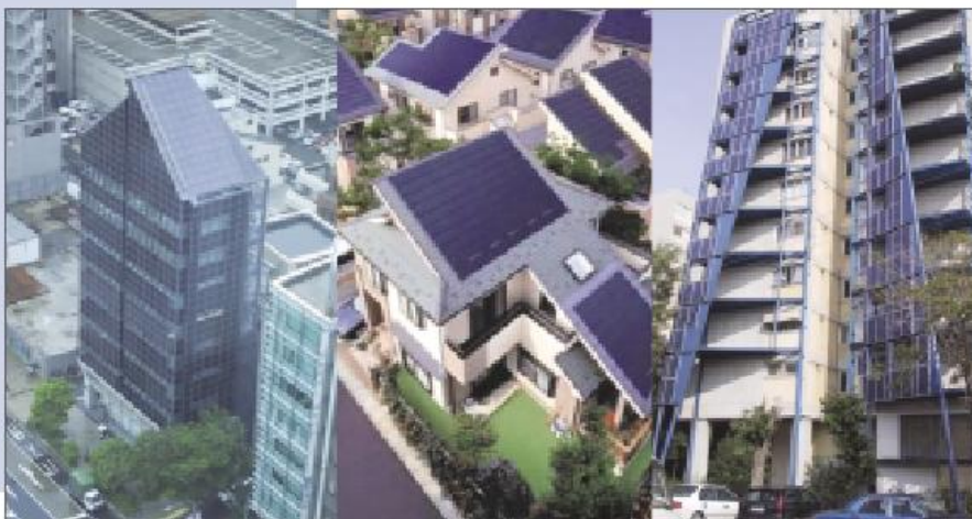
Minami Co. Ltd., Kobe city, Japan, 76,7 kWp Φ/Β ενσωματωμένα σε όλες τις όψεις και την οροφή κτιρίου γραφείων στην πόλη Kobe της Ιαπωνίας.
