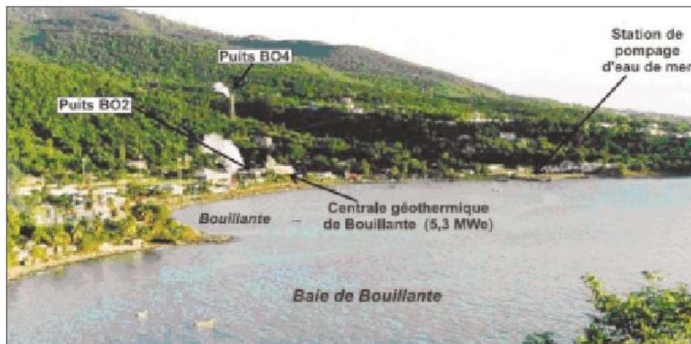
Φωτ.2. Οι εγκαταστάσεις παραγωγής ηλεκτρικής ενέργειας στο Bouillante της Γουαδελούπης (Γαλλικές Αντίλλες) [5]
