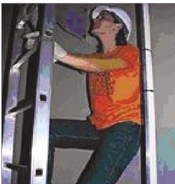
Εικόνα 2. Άνοδος εργαζομένου στην νασέλλα, από την εσωτερική σκάλα του πυλώνα. Κίνδυνος πτώσης από μεγάλο ύψος
