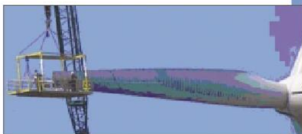
Εικόνα 1. Εργαζόμενοι εκτελούν συντηρήσεις στο hub και τις πτέρυγες.
