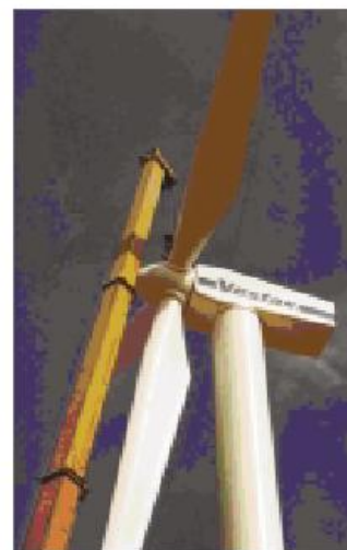
Εικόνα 4. Εργασίες στην νασέλα με τη χρήση γερανοφόρου οχήματος.
