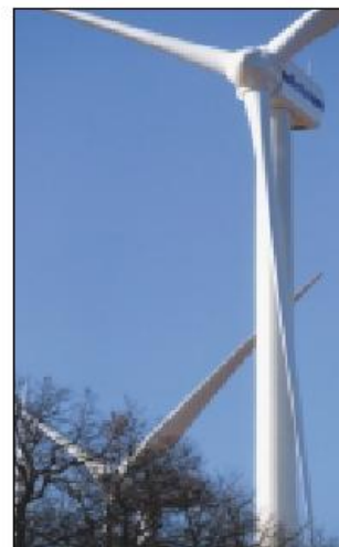
ΑΠ Δίδυμος ισχύος 26 MW στη Θράκη
