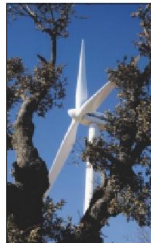
ΑΠ Δίδυμος ισχύος 26 MW στη Θράκη
