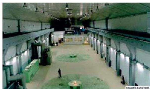
Φωτό 3: Σταθμός Παραγωγής ΥΗΕ θερμασμού ποτ. Νέστος. (Φράγμα Λιθόρρυπτο, Ύψος 172 m, Ισχύς 3x128 MW, Αναστρέψιμο, Παραγωγή: 440 GWh από εισροές, 615 GWh από άντληση)
