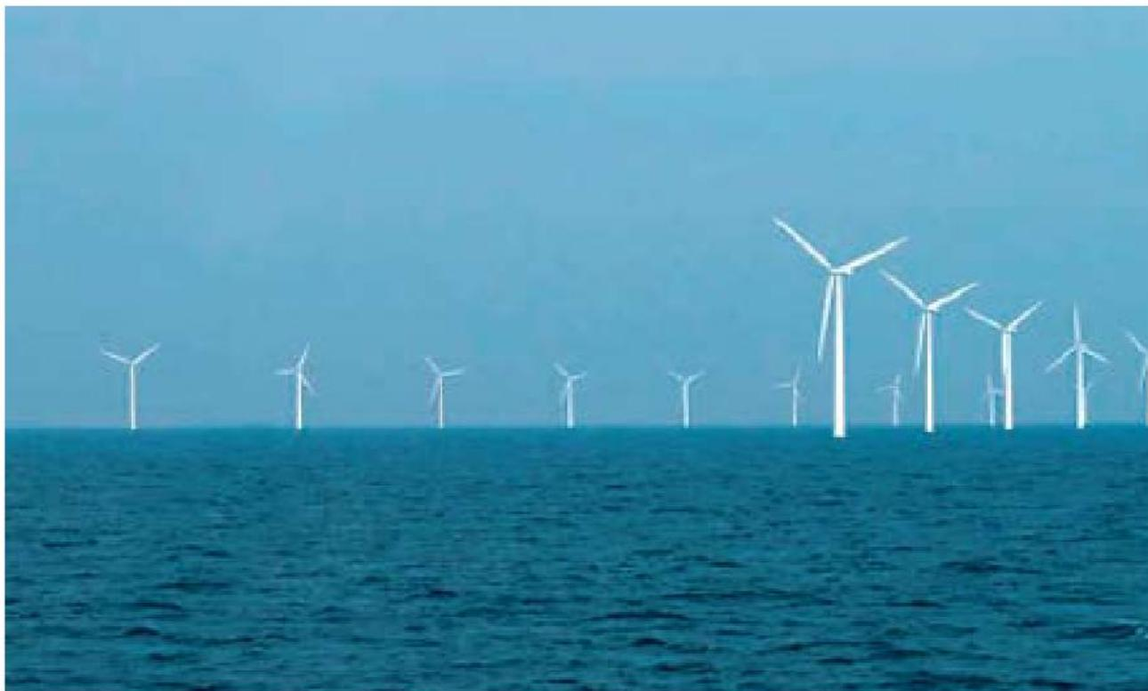
**Η**εγκατάσταση μιας ανεμογεννήτριας στην ανοιχτή θάλασσα είναι δαπανηρή αλλά και τεχνικά δύσκολα υλοποιήσιμη. Στον σχεδιασμό πρέπει να ληφθούν υπόψη πολλοί και διαφορετικοί παράγοντες, ενώ για να περιοριστεί το κόστος, η εγκατάσταση τους γίνεται μόνον σε ρηχά νερά, Βάθους έως 50 περίπου μέτρων.
