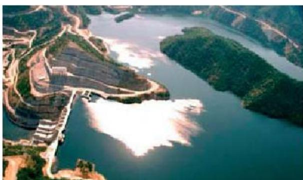
Φωτό 2: Φράγμα και ταμιευτήρας ΥΗΕ Πλατανόβυρου ποτ. Νέστος. (Φράγμα από Κυλινδρούμενο Σκυρόδεμα RCC, Ύψος 95 m, Ισχύς 2x58 MW, Παραγωγή 240 GWh )
