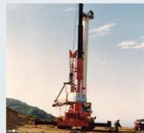
Εργασίες ανέγερσης έτος 1990. Στην κορυφή του πύργου της Α/Γ σε ύψος 25m μεθωτός της ΔΕΗ, ετοιμάζεται για την τοποθέτηση της ατράκτου που ανεβάζει ο γερανός.
