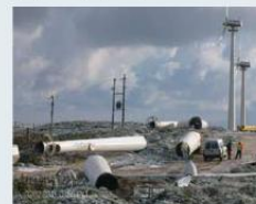
Τμήματα πύργου των ανεμογεννητριών έτοιμα να φορτωθούν σε νταλίκες για μεταφορά προς ανακύκλωση...
