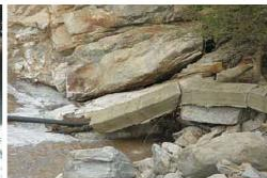
3. Καταστροφή αγωγού ύδρευσης και αποδότηση των βροχικών μεγεθών στα οποία αυτά σπάζουν, λόγω της δράσης του υπερχειλιστή του φράγματος Π.α.
