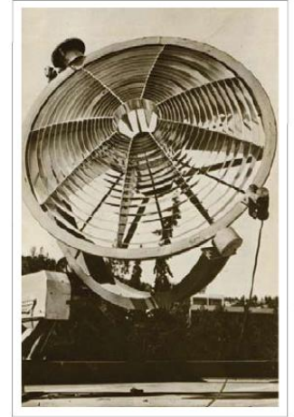
Εικόνα 3 Φωτογραφία ΣΟΚ, με τις νέες ανακλαστικές επιφάνειες, όπως κατασκευάστηκε το 1974 στο ΕΚΕΦΕ ΔΗΜΟΚΡΙΤΟΣ.
