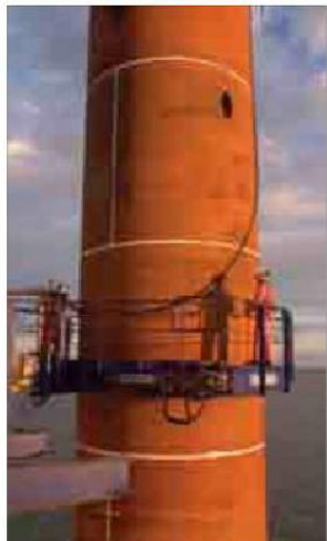
4 Ένας πάσσαλος εγκαθίσταται - Kentish Flats Offshore Wind Farm
