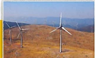
Οι σύγχρονες ανεμογεννήτριες έχουν εξελιχθεί πλέον σε σχεδόν αθόρυβες μηχανές. Σε αποστάσεις μεγαλύτερες των 200 μέτρων, ο θόρυβος περιστροφής των πτερυγίων συνήθως καλύπτεται πλήρως από το θόρυβο του ανέμου μέσα στα φύλλα των δέντρων και των θάμνων. Σε απόσταση 300 μέτρων, μια σύγχρονη ανεμογεννήτρια δεν ακούγεται περισσότερο από το ψυγείο στην κουζίνα.
